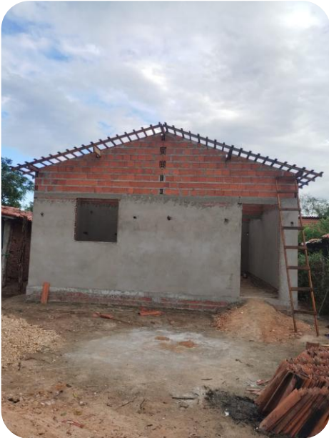
Het nieuwe huis van Dona Rosa in aanbouw, met het pas geplaatste dakgeraamte.
